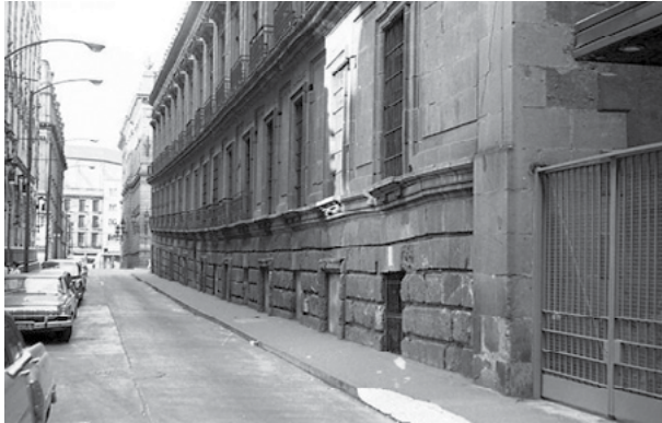
Figura 8. Callejón de la Condesa, antes de la intervención de 1970-1976. El nivel original del edificio no había sido recuperado. Fotografía del ingeniero Alberto Lepe Zúñiga, 1964, colección del AHPM.
