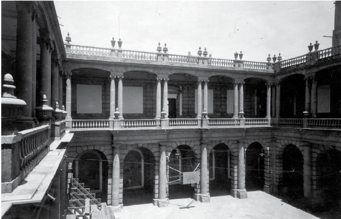
Figura 14. Patio principal del edificio convertido en cancha deportiva. Fototeca Constantino Reyes-Valerio, CNH+Conaculta, INAHMEX, XXVI-85.
