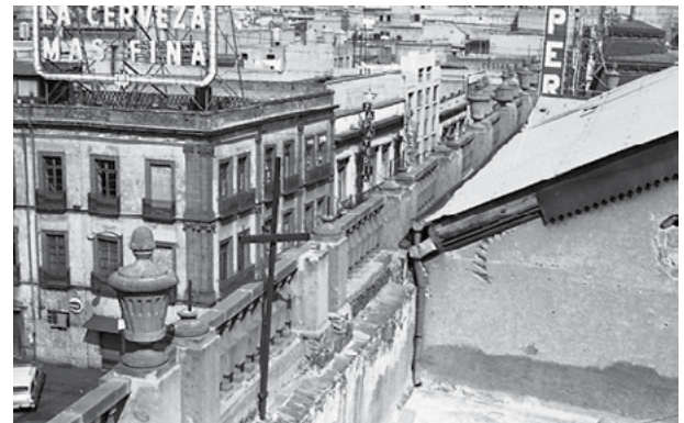
Figura 6. Construcción agregada en la parte oriente de la azotea del edificio, perteneciente a la Secretaría de Fomento. Obra demolida entre 1970-1976. Fotografía del ingeniero Alberto Lepe Zúñiga, 1964; colección del AHFM.
