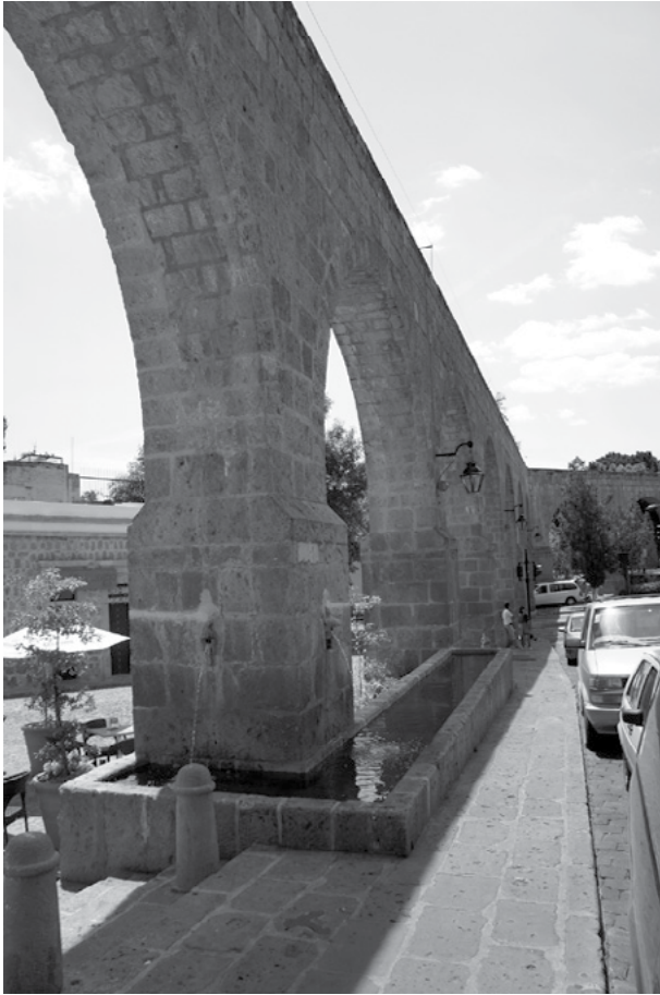
Figura 11. Detalle de pila en el acueducto. Fotografía del Archivo Torres-Salomao.
