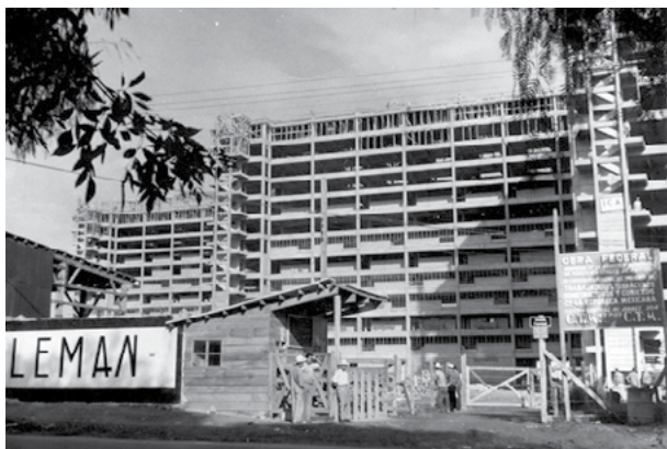
Figura 1. Construcción del Centro Urbano Presidente Alemán (CUPA), fachada oriente del edificio núm. 3, Dirección de Pensiones Civiles, "Cooperación técnica para ayudar a resolver el vital problema de la habitación", México, 1949, p. 38.
