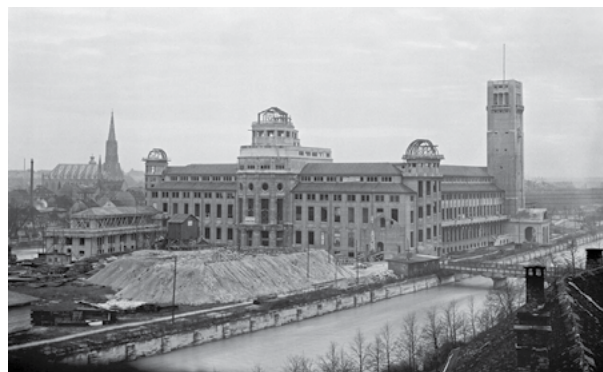
Figura 1. Vista general de la obra del Deutsches Museum ca. 1914, con los techos y cúpulas de nuevo sin sus cubiertas de cobre. Fotografía del Deutsches Museum.
