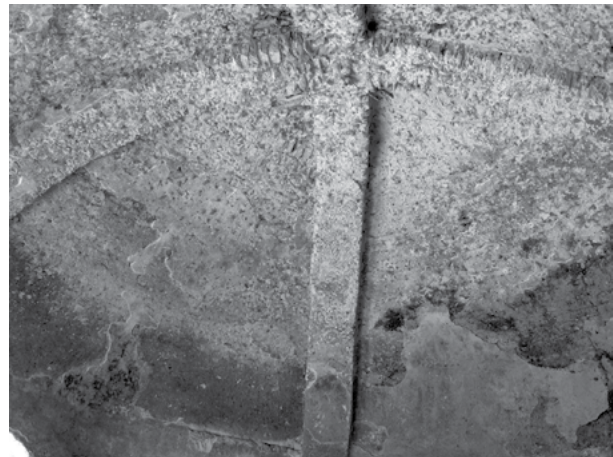
28. Arcos fajones diagonales y aparejo recto de la cubierta de la noria del ex convento de La Asunción en Mama, Yucatán. Fotografía de Manuel Arturo Román Kalisch.
