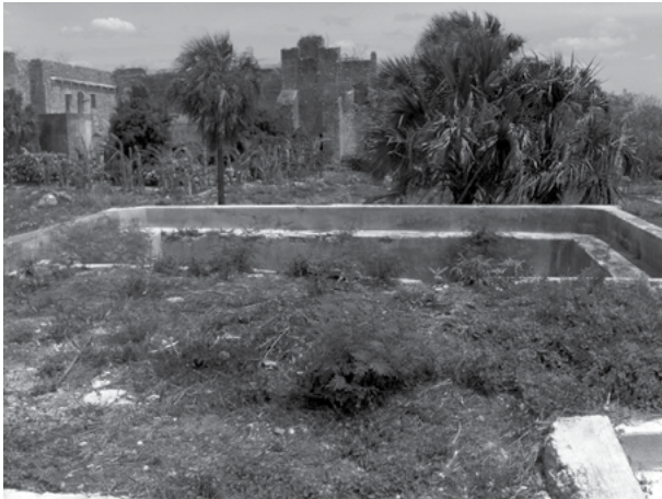
Figura 32. Tanque de almacenamiento de la noria del ex convento San Agustín en Tekantó, Yucatán. Fotografía de Manuel Arturo Román Kalisch.
