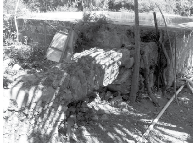
Figura 37. Canal de conducción con arcos de la noria del ex convento San Buenaventura en Homún, Yucatán. Fotografía de Manuel Arturo Román Kalisch.
