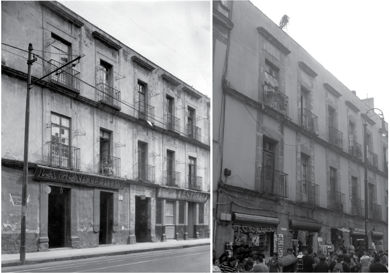
Figuras 15. Comparación de la fachada del inmueble de Correo Mayor 10, donde se aprecian las modificaciones realizadas en la planta baja. Derecha: Fototeca Constantino Reyes-Valerio, CNMHINAH, Correo Mayor 10, VOA4TVII, XXXVIII-81. Izquierda: fotografía de Gabriela Sánchez Reyes.
