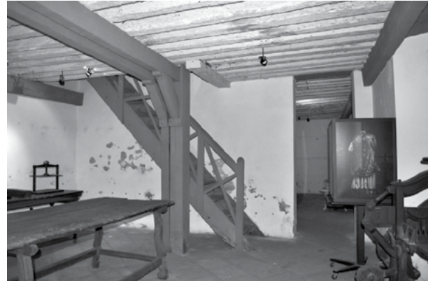
Figura 14. Escalera de un tramo que comunica con la pieza alta de una de las accesorias de "taza y plato" del Colegio de las Vizcaínas. De igual forma se aprecia la viguería del entrespiso. Fotografía de Gabriela Sánchez Reyes.
