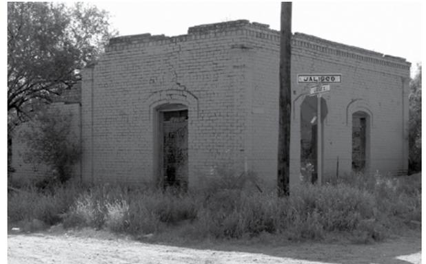
Figura 7. Salón ubicado en la plaza principal de Colombia, Nuevo León. En este caso se observa el empleo de ladrillo cocido a alta temperatura; es difícil resolver si se trataría de material proveniente de ladrilleras estadounidenses, porque en ambos lados del río Bravo se formó una tradición de fabricación y empleo de dicho material desde al menos finales del siglo XIX. Fotografía de Alejandro González Milea, 2009.
