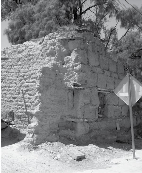
Figura 4. Aspecto constructivo de muro en Villa del Progreso, Coahuila. En las nuevas poblaciones el imperativo de construir con materiales del lugar provocó que intentaran resolverse problemas con los medios disponibles. En la imagen se aprecia el refuerzo de un muro de adobe empleando lajas y recubrimiento de sillar de cantera. Fotografía de Alejandro González Milea, 2008.
