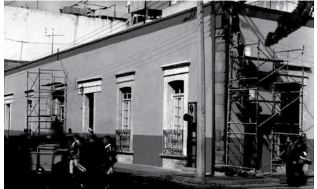
Figura 4. Trabajos de conservación de la Casa Márquez en el Programa Revive. Fotografía de Alejandro Acosta Collazo, noviembre de 1997.
