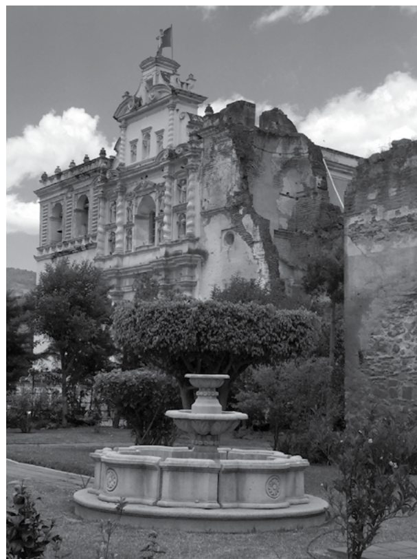
Figura 4. Iglesia San Francisco, en Antigua Guatemala, dañada por los sismos de 1773. Fotografía de Susana Palma, 2015.
