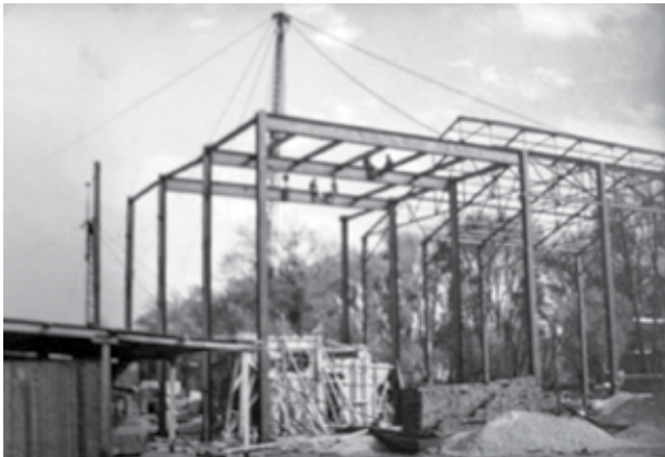
Figura 6. Parte del armado en metal. Se aprecia el brazo de una grúa y cinco obreros trabajando a gran altura. Colección Alberto Lenz Krahl.
