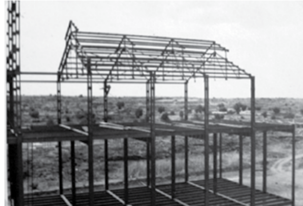
Figura 7. Primer armado de la cercha, casi concluido. Colección Alberto Lenz Krahl.
