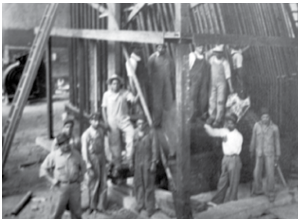
Figura 10. Obreros y jefe de obras posando junto a los serpentines de la caldera de la Fábrica de Celulosa. Colección Alberto Lenz Krahl.
