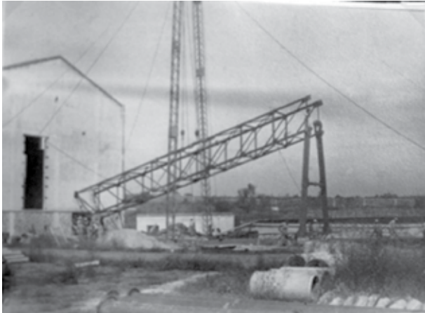
Figura 12. Chiper con el arranque de la banda transportadora que conducía los chips o fragmentos de madera a los hervidores. Nótese la proporción humana en relación con el contexto material. Colección Alberto Lenz Krahl.
