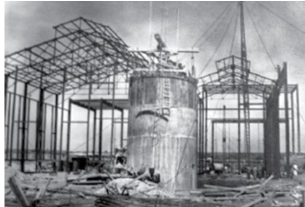
Figura 8. A la par del armado de las estructuras de los edificios productivos también tomaba forma el "chacuaco" en concreto armado y en secciones. Colección Alberto Lenz Krahl.
