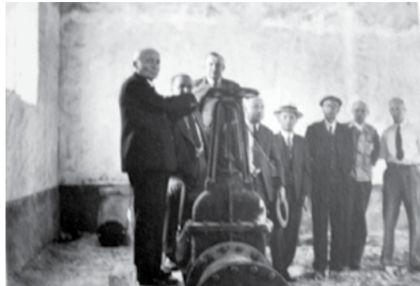
Figura 15. Alberto Lenz Adolph abriendo por vez primera una de las válvulas de paso que conducirán el agua a las instalaciones de la Fábrica de Celulosa. Colección Alberto Lenz Krahl.
