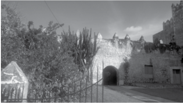
Figura 14. Fachada del convento con el acceso principal. Fotografía de David Pérez Fernández.
