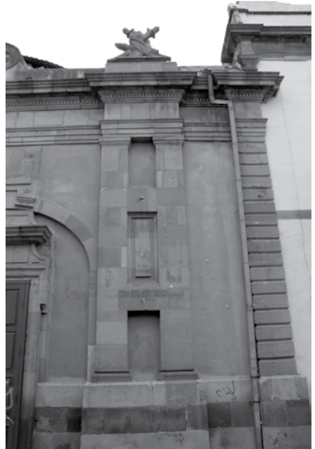
Figura 4. Pilastras unidas y pilastra extrema del Teatro Alarcón. Fotografía de Hugo Cuéllar, noviembre de 2014.
