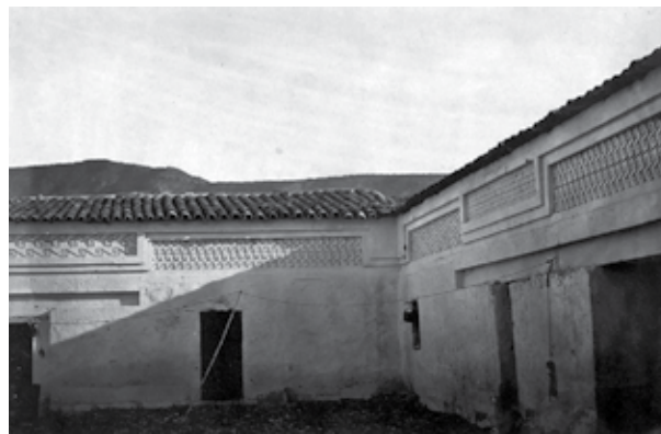
Figura 4. Interior de la casa del cura en Mitla, Izamal. Mapoteca Manuel Orozco y Berra. Reprografía de Agustín Estrada, Juliana Bittencourt y Patricia Carrillo.
