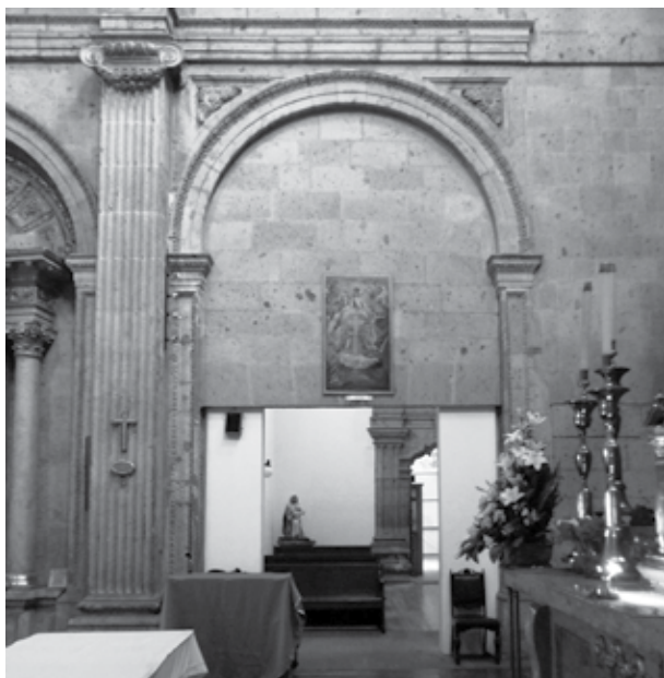
Figura 12. Vano practicado al muro norte del templo de Santa María de Gracia en 1914.
