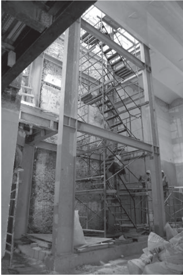
Figura 20. Proceso de intervención del espacio de Monolitos para introducir un elevador en 2008; a los 3 m se localizó un piso de estuco azteca, correspondiente al Palacio de Moctezuma. Se realizó en un pequeño tragaluz anterior reducido, lo que obligó a destruir la cimentación virreinal del muro de carga. Fotografía de Elsa Hernández Pons.
