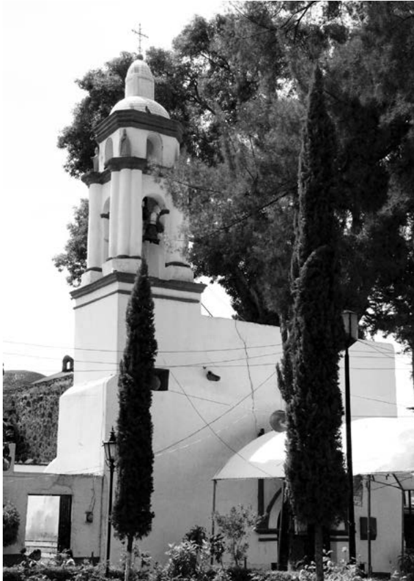
Figura 1. Templo de San Luis Obispo de Tolosa. Fotografía de Ingeniería Experimental, S. A. de C. V. (en adelante IESA).
