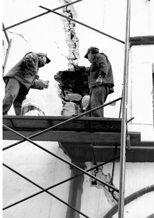
Figura 23. Proceso de remamposteo en la fractura principal sobre la fachada, vista exterior. Fotografía de Rogelio Vargas Villanueva, 2015.
