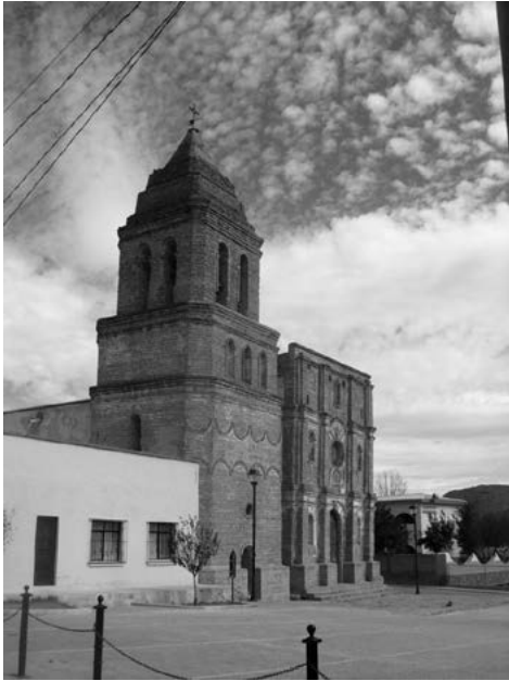
Figuras 7 y 8. Ejemplos de la arquitectura misional sonorenses; a la izquierda se observa la iglesia ubicada en la población de Arizpe, en la región Opata, construida a base de adobe y ladrillo en sus muros; a la derecha se observa la de Caborca, de fábrica franciscana, ubicada en la Pimería Alta, ambas en el norte del actual estado de Sonora. En la diversidad de la propuestas formales de su arquitectura radica su valía y reconocimiento. Fotografías de Francisco Hernández Serrano, febrero de 2011.
