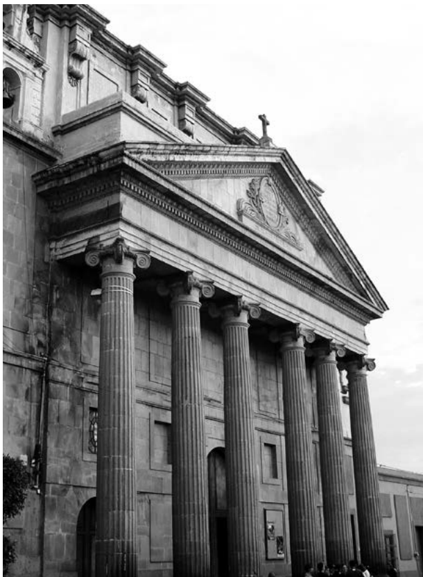
Figura 15. Fachada hexástila del templo de Teresitas. Fotografía de MRMA.
