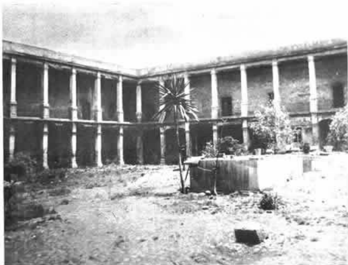
Fotografía de principios de siglo que muestra el claustro antes de su degradación.
