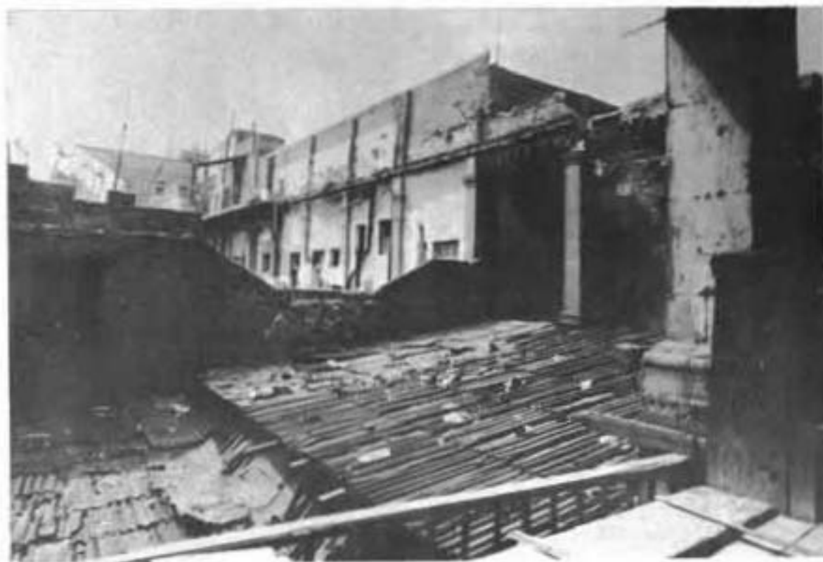
Aspecto que presentaba el claustro antes de los trabajos de restauración y reconstrucción.
