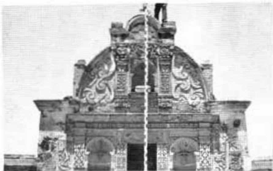
Cuando se trate de medir por este sistema torres con remates esféricos, es recomendable que la cinta sea colocada sobre uno de los costados de la torre para facilitar el trabajo en el gabinete, llevando perpendiculares a la cinta del punto medio de los diferentes elementos arquitectónicos que desearemos obtener. (Fig. 4)
