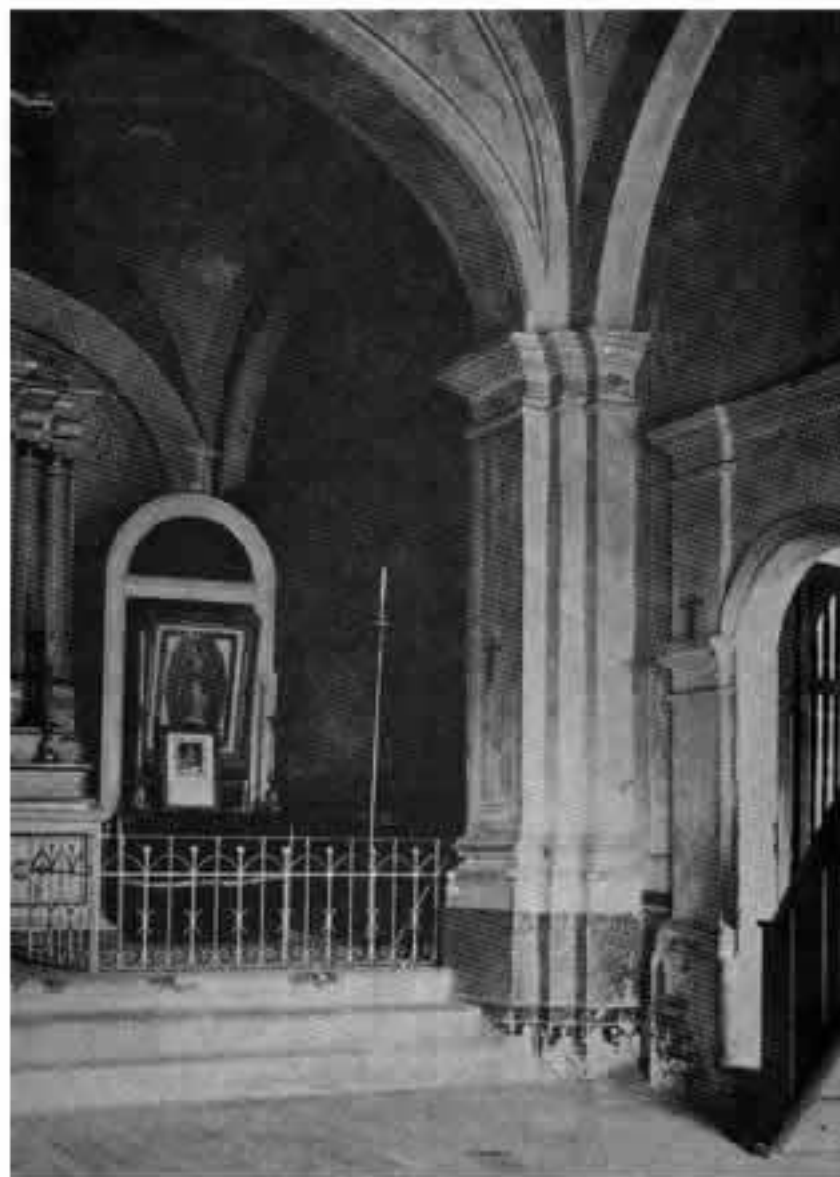
Interior de la iglesia de San Pedro Verona Mártir (antes de la restauración).
