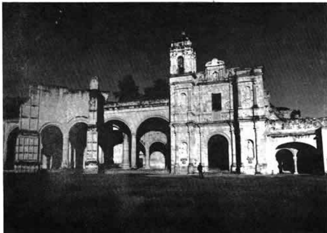
Iglesia y capilla abierta del ex convento dominico de Teposcolula, Oaxaca
