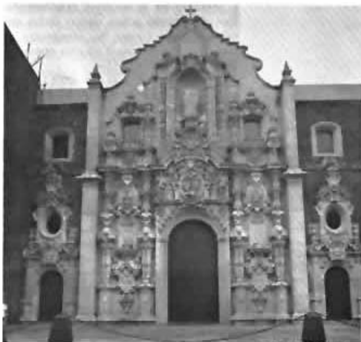
Fachada de la Iglesia de San Felipe Neri, México.
