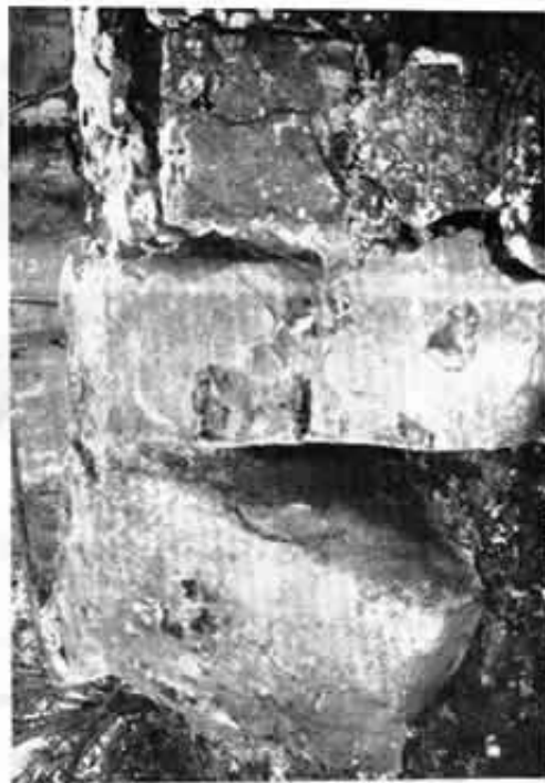
Figura 13. a. Muro interior del tanque, con algunas grietas profundas que urge restaurar, y el piso de piedra bola recubierto con estuco; b. Acercamiento del vertedero con la raíz que aflora sobre el bloque de canchales; c. Vista de la pila menor de forma rectangular, con muros estacados y piso de piedra bola con recubrimiento; d. El vertedero de agua de la pila grande a la pequeña.
