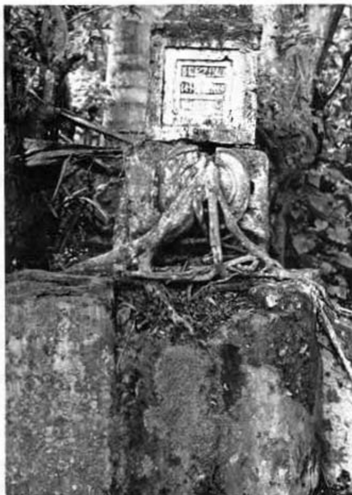
Figura 10. Acercamiento del vertedero de la pila y la raíz del amate que lo desplazó; arriba de éste, la piedra conmemorativa que se ha despegado por la fuerza de la raíz.
