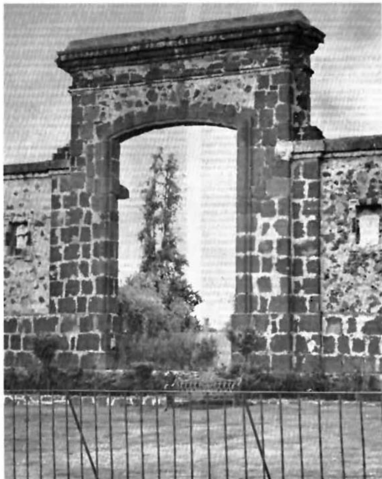
Calzada México-Tajiquahuac esquina Severino Cordero
