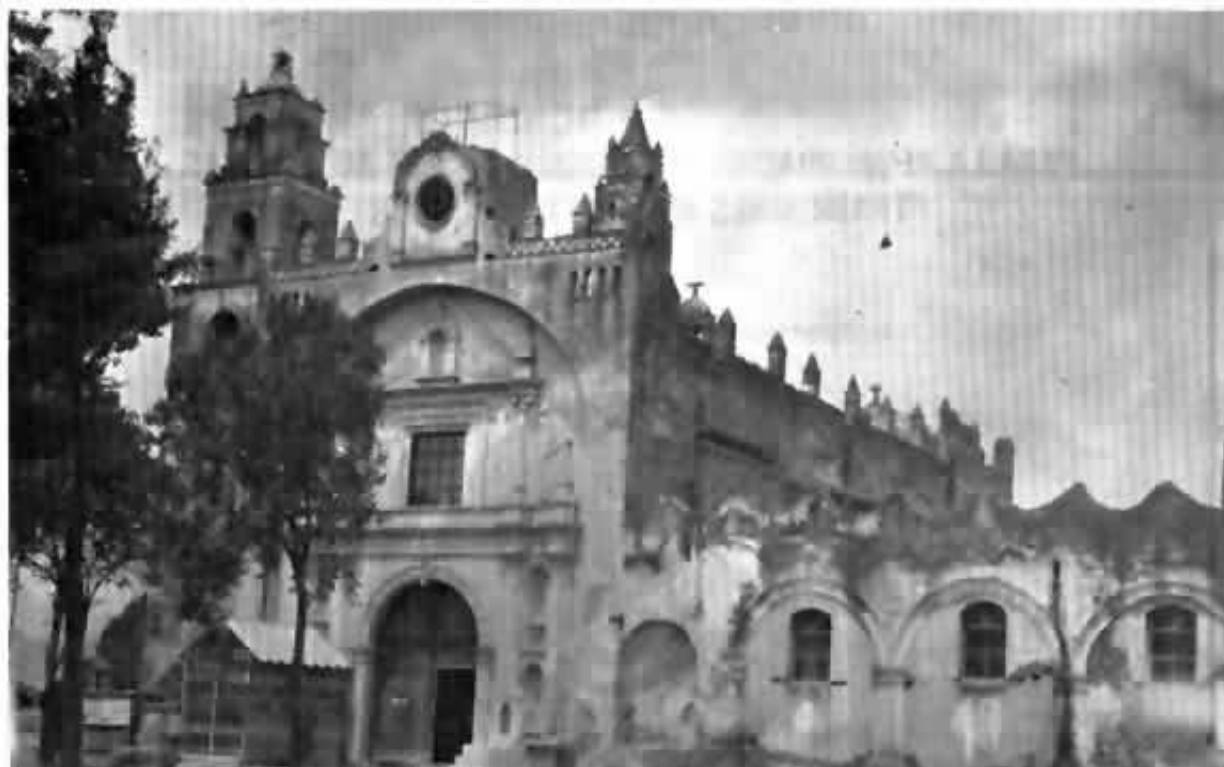
Fachada y portada del templo, Atzacan Milpa Alta, México.
