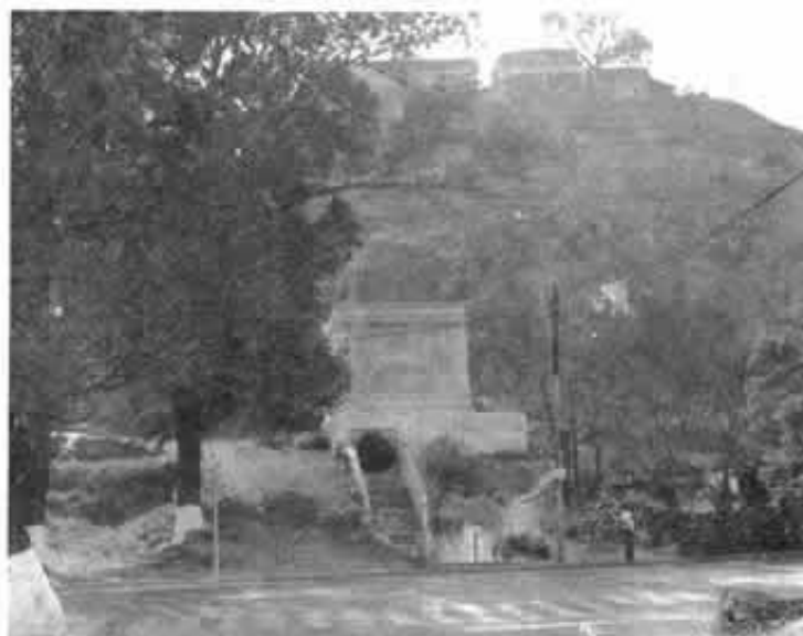
Caseta de control del excedente de agua. Santo Cruz Acaalpexca
