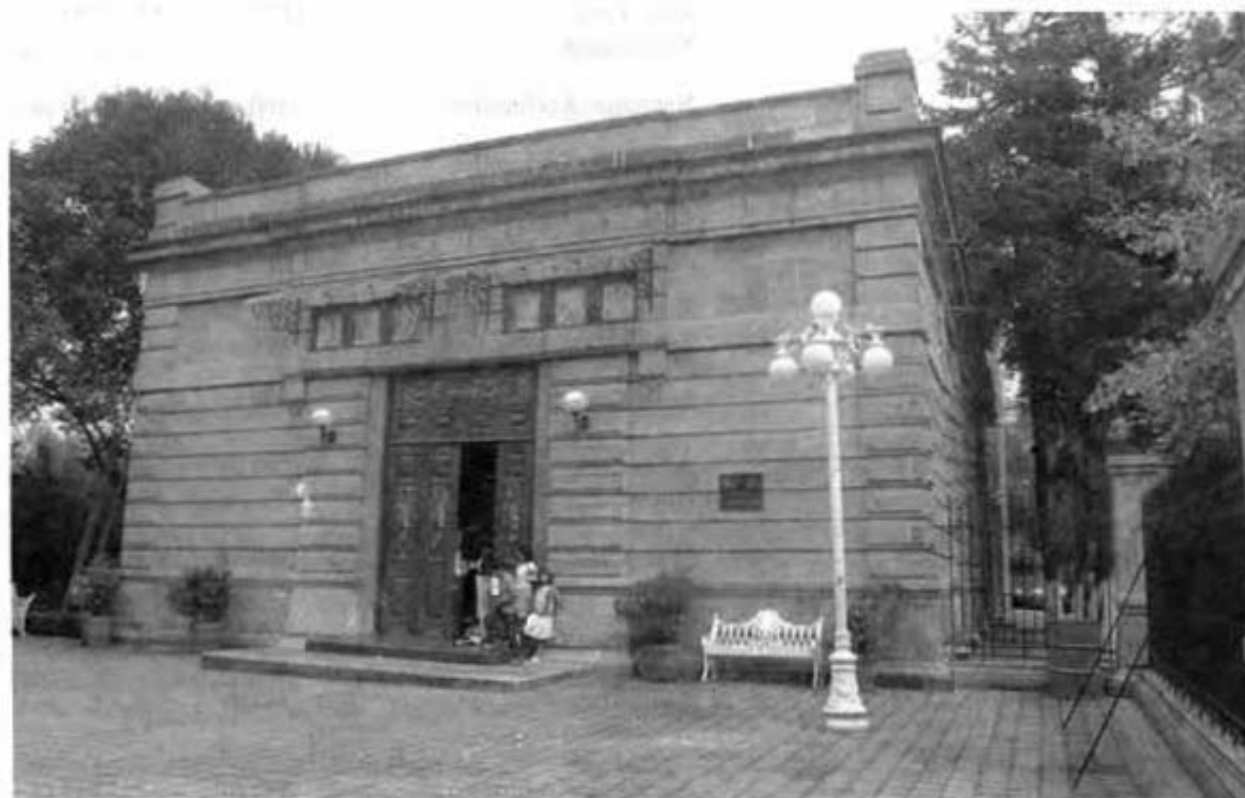
Casa de Bombas de la Notia
