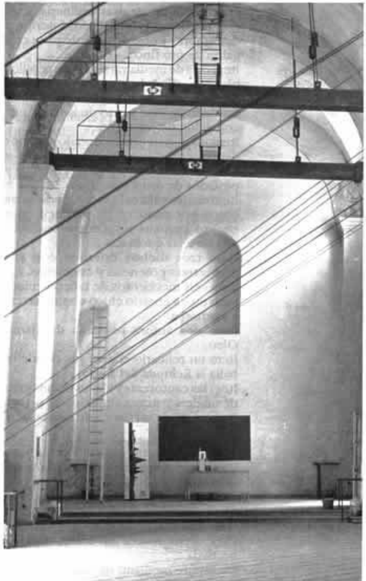
Trabajos de restauración
