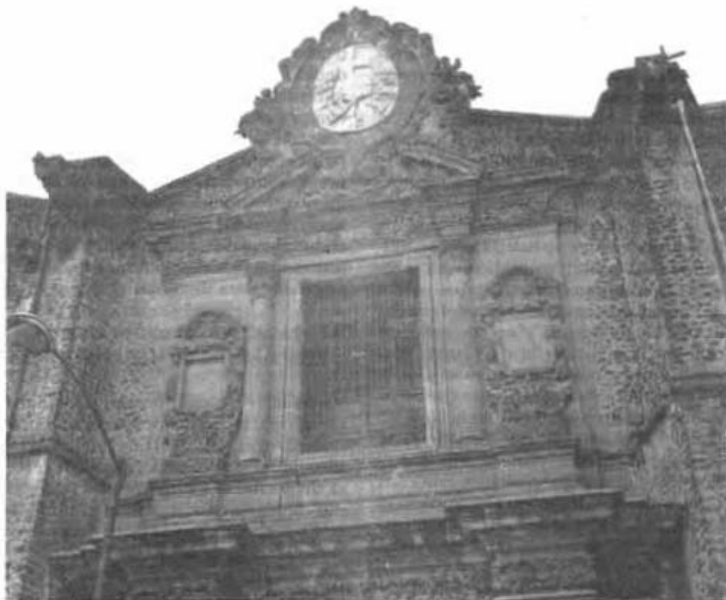
Templo de La Concepción, vista de la parte alta
