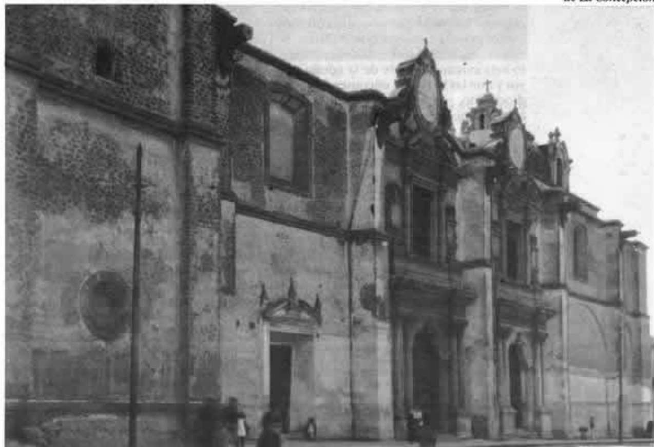
Fachada del Templo de La Concepción
