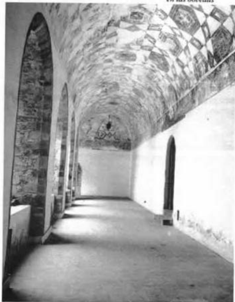
Restos del decorado en las bóvedas
