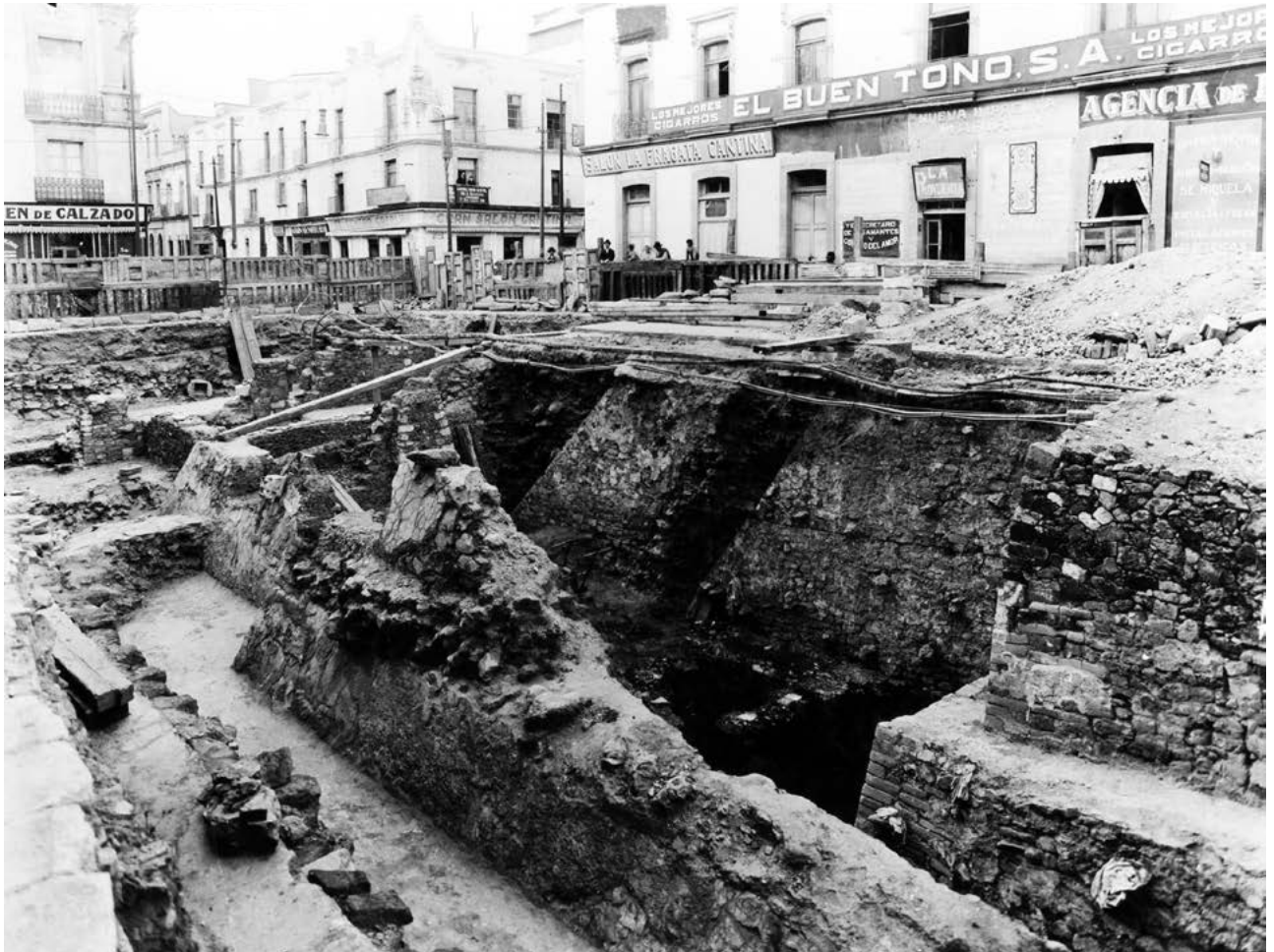
Figura 13. Proceso de demolición de las casas de la condesa de Peñalba donde Manuel Gamio encontró los vestigios del Templo Mayor, y enfrente, la casa que se edificó sobre el solar de Alonso de Ávila con varias accesorias, como la que albergó el salón cantina La Fragata, Fotografía del Sinafo, 688933.
