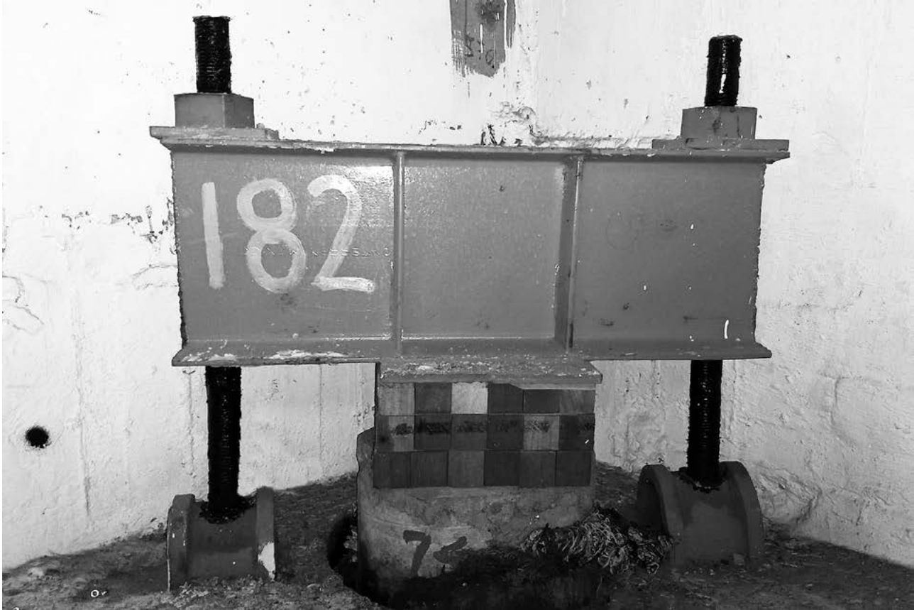
Figura 10. Pilotes de control en la Antigua Basílica de Guadalupe. Fotografía de Marcela Saldaña Solís, 2017.
