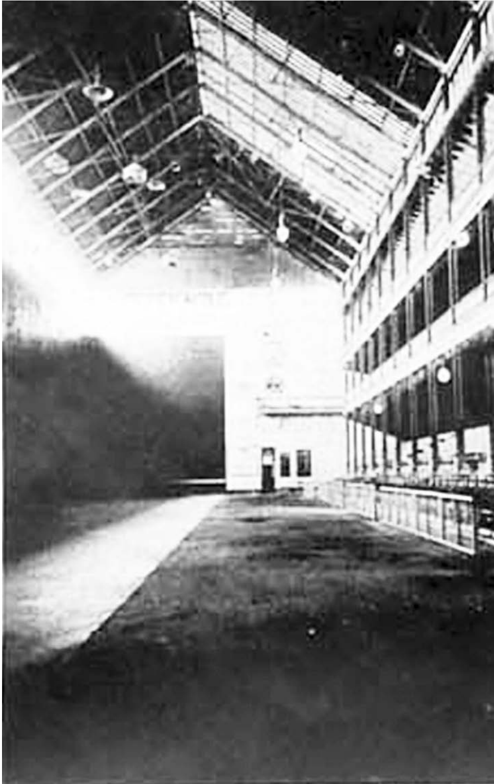
Figura 18. Interior del Frontón Nacional, donde se aprecia la techumbre de hierro. Fuente: El Mundo Ilustrado , 1 de enero de 1904. Agradezco a la doctora en historia Martha Eugenia Alfaro Cuevas, del INBA, por proporcionarme la imagen.
