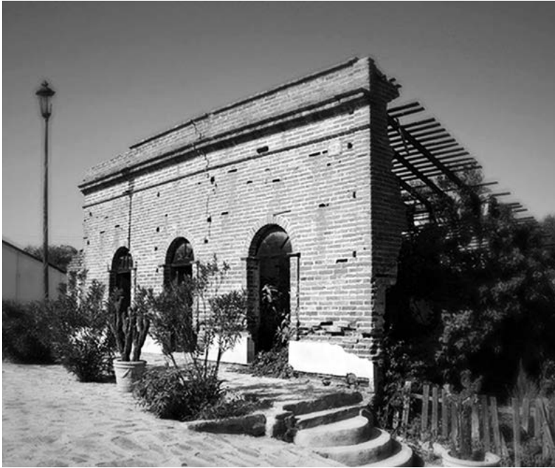
Figura 9. Ruinas industriales en El Triunfo, Baja California Sur. Fotografía recuperada de < www.bajachallenge.com >.
