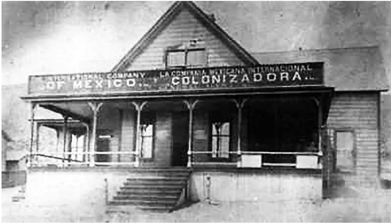
Figura 12. Edificio de la International Company of México. Este inmueble de madera se inauguró a finales del siglo XIX en Ensenada. De dos plantas y estilo victoriano, fue construido en Inglaterra y armado en el centro histórico de este puerto. Fuente: www.inah.gob.mx . Fotografía recuperada de http://resena.ens.uabc.mx/ .
