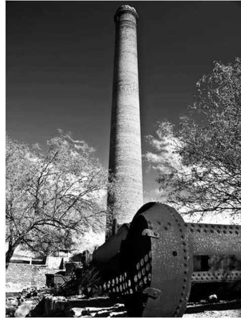
Figura 10. Chimenea La Ramona, de 47 m, presuntamente diseñada por Gustave Eiffel, construida entre 1876 y 1886 en El Triunfo, Baja California Sur. Fotografía recuperada de < http://tallerfotobcs.blogspot.mx/ >.
