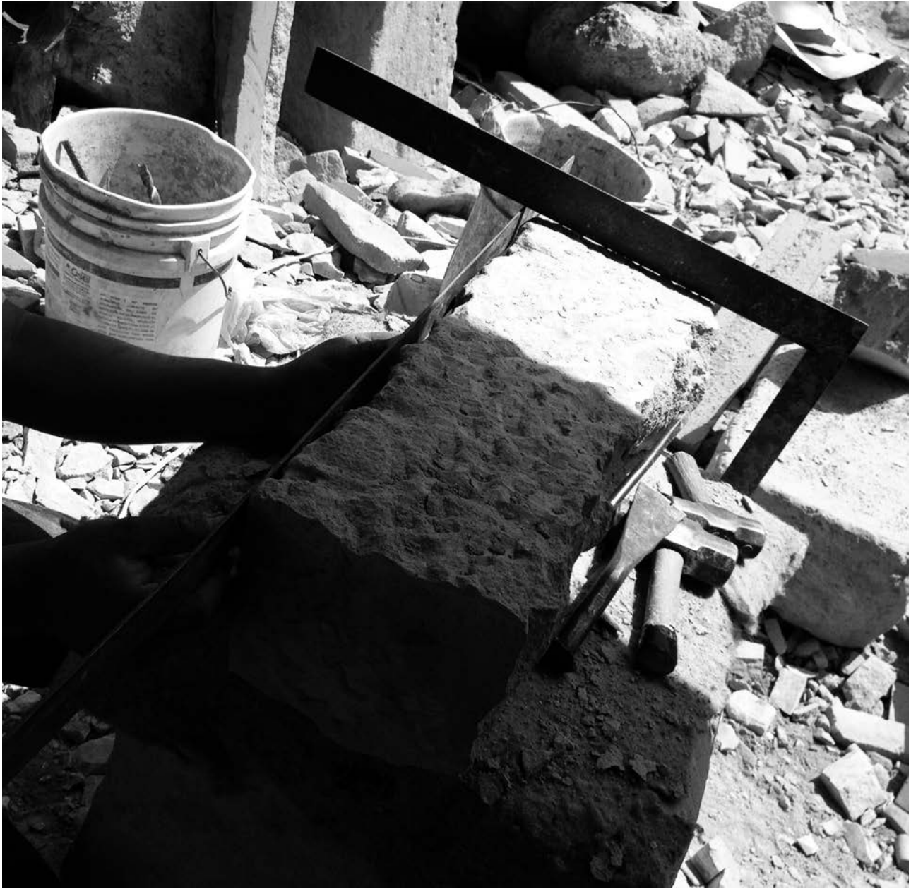
Figura 9. Actividad de "bornear la piedra" ayudándose de escuadras y reglas para lograr un bloque cúbico. Fotografía de Rocio Ivvett Oros Guel.
