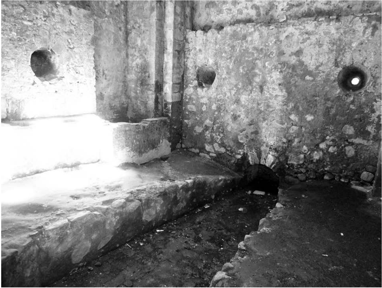
Figura 3. Canal en el interior de la cloaca, el cual servía para desechar los debris por medio de una circulación constante de agua. Fotografía de Daniel Pastrana.
