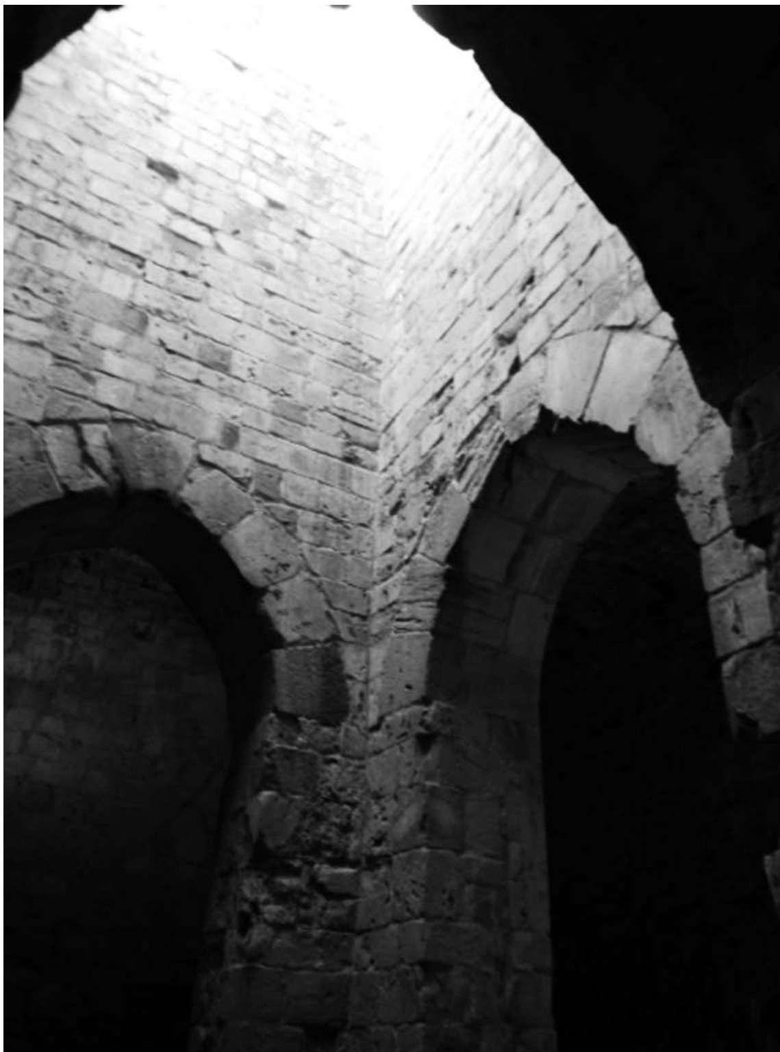
Figura 10. Cloaca de Yanhuilán. Es notable el patio interior para el manejo de aromas y permitir una recolección del agua de lluvia utilizada para el desalajo. Fotografía de Tania Fuentes.
