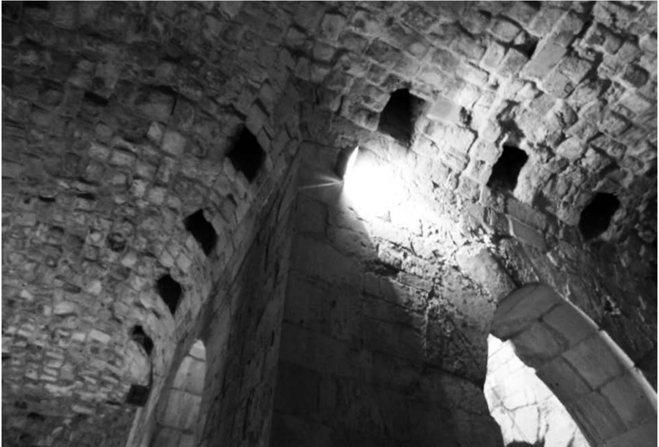
Figura 11. Cloaca de Yanhuatlán. Vista de las bóvedas y los orificios de desalojo. Fotografía de Tania Fuentes.
