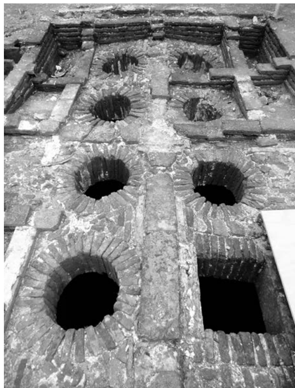
Figura 5. Vista de las ruinas de las secretas. Se observan el sistema constructivo y las claves de los arcos por su extradós. Fotografía de Daniel Pastrana.
