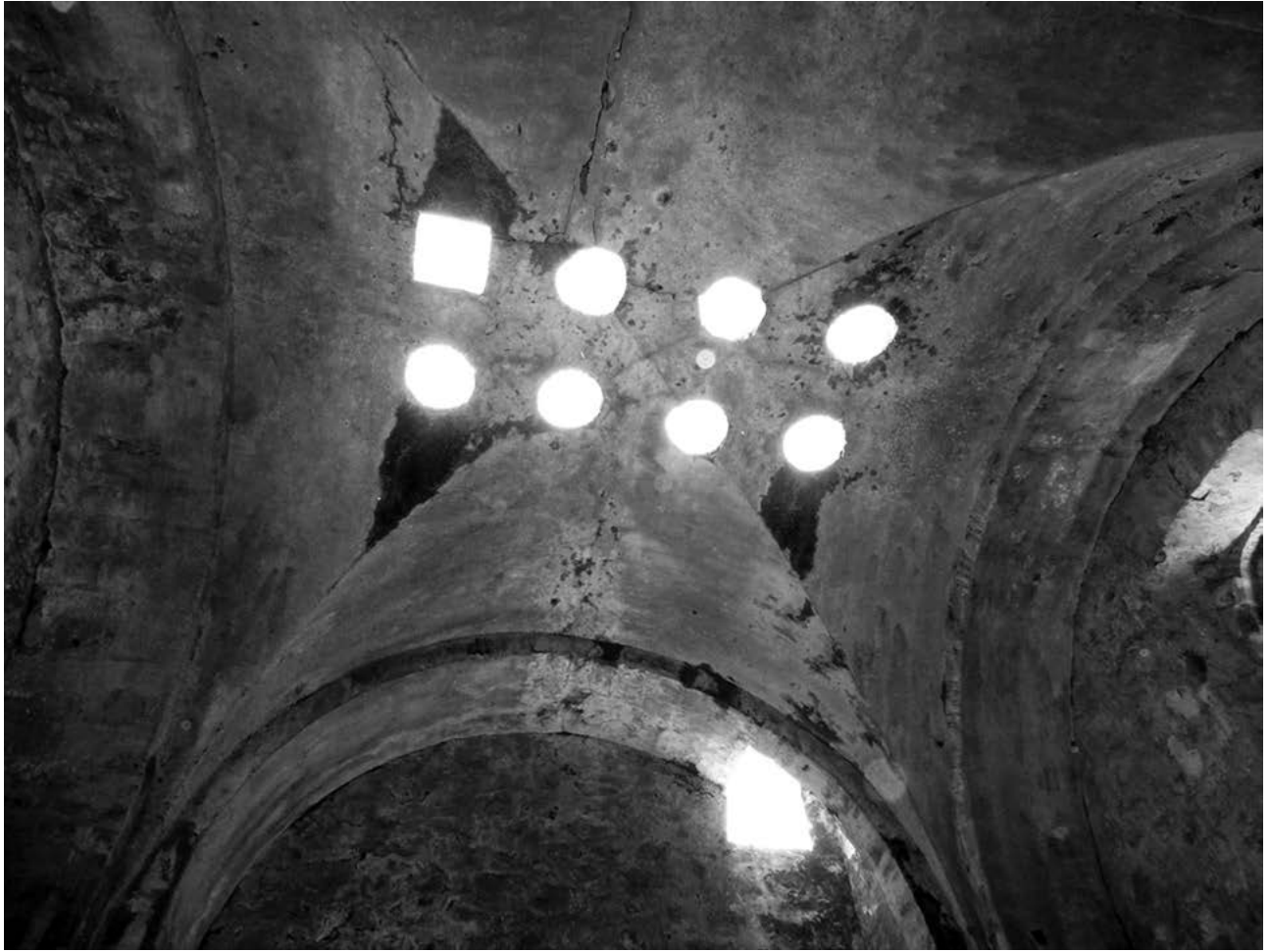
Figura 4. Interior de la cloaca. Se observa la forma de la bóveda, así como los orificios en el techo que correspondían a cada sitial. Fotografía de Daniel Pastrana.
