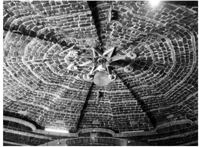
Figura 9. A la izquierda, bóveda del coro del templo de San Lorenzo (planta baja), y a la derecha, detalle de la misma. Fotografías de Leopoldo Rodríguez Morales, 2015.
