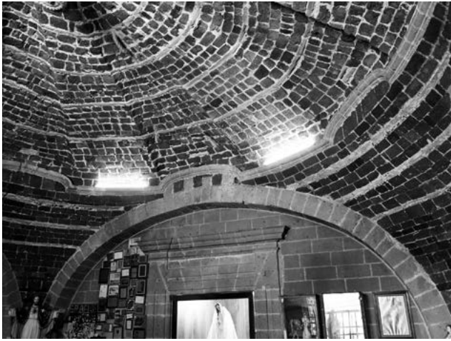
Figura 9. A la izquierda, bóveda del coro del templo de San Lorenzo (planta baja), y a la derecha, detalle de la misma. Fotografías de Leopoldo Rodríguez Morales, 2015.
