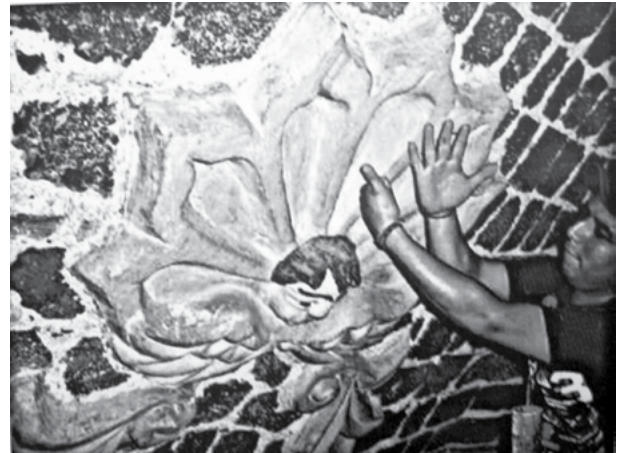
Figura 15. Abajo, a la derecha, detalle de la cúpula, donde se aprecian las dovelas cuando no tenía su aplanado; arriba, la cúpula en la actualidad, con su nuevo aplanado. Imagen elaborada con nube de puntos con fotografía, escáner 3D, CNMHINAH.
