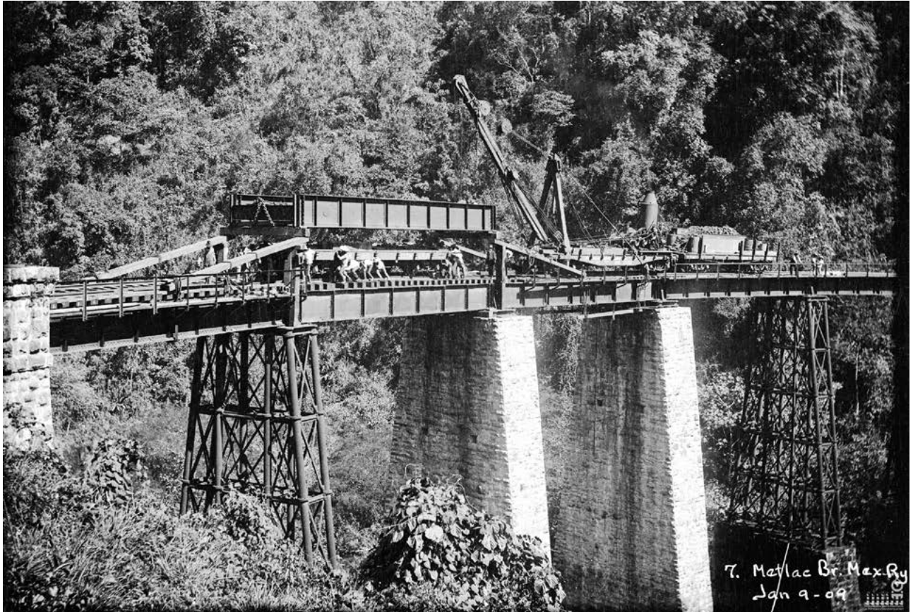
Figura 10. El puente de Metlac en 1909. La fotografía fue tomada en enero de ese año, cuando se efectuó el primer cambio de vigas. Se nota que dos de los apoyos originales ya se habían reforzado por mampostería. Fuente: Fondo Ferrocarril Mexicano. Secretaría de Cultura/CNIPPCF/CEDIF.
