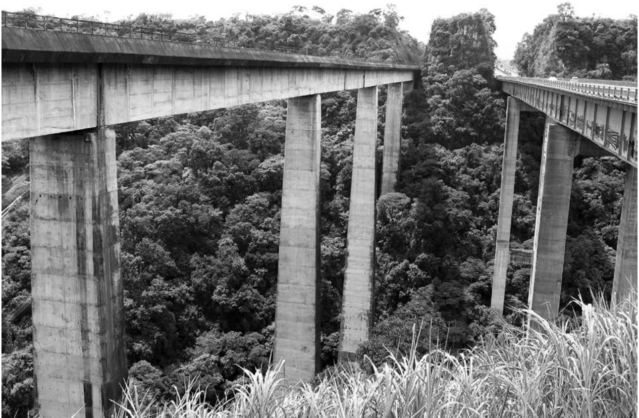
Figura 11. Los nuevos puentes de Metlac: de concreto para el ferrocarril (izq.) y de acero para la autopista (der.). Fotografía de Dirk Bühler.
