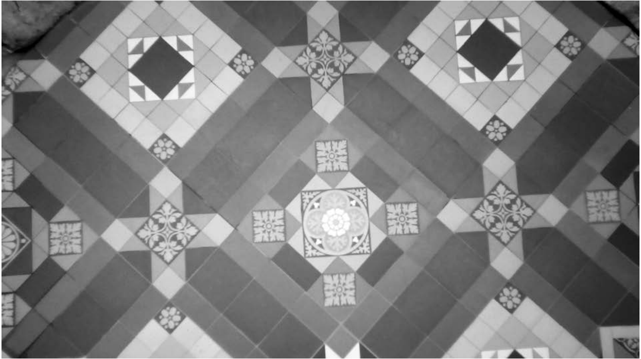
Figura 9. Piso del pórtico después de la restauración de la casa Rivas Mercado. Fotografía de Teresa Rodríguez Méndez, 2017.
