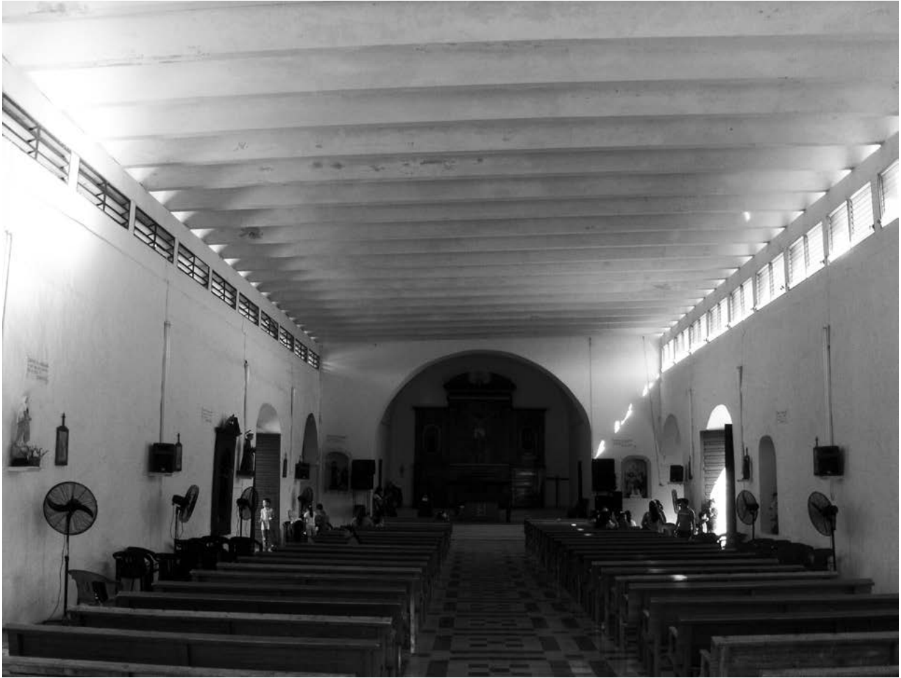
Figura 9. Vista hacia el presbiterio, donde se observa la techumbre plana de concreto prefabricado y las ventanas adosadas en los muros laterales en la nave de la capilla de San Francisco, Dzilam González, Yucatán. Fotografía de los autores.
