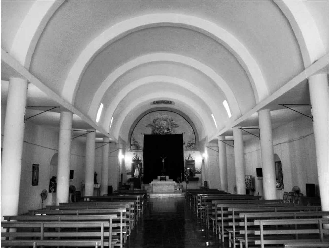
Figura 2. Vista del interior de la nave hacia el presbiterio, con la cubierta abovedada de concreto armado en la capilla de Santiago, Muxupip, Yucatán. Fotografía de los autores.
