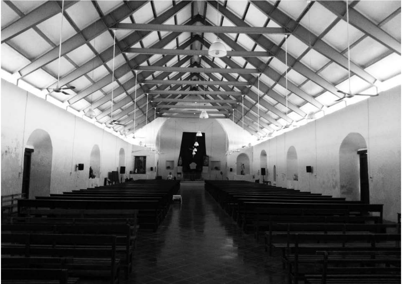
Figura 11. Vista del interior de la nave hacia el presbiterio, donde se aprecia la estructura metálica de la nueva techumbre en la capilla de San Antonio, Ucí, Yucatán. Fotografía de los autores.
