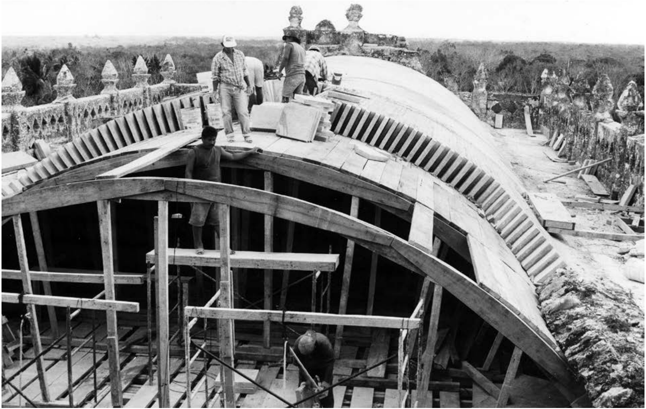
Figura 4. Vista durante la ejecución de la obra de la nueva bóveda de la iglesia conventual de San Antonio, Uayma, Yucatán. Fotografía tomada de Martha Pacheco León et al., Memoria de restauración de un inmueble histórico. Templo y ex convento de Santo Domingo, Uayma, Yucatán, México, Gobierno del Estado de Yucatán, 2007 , p. 25.
