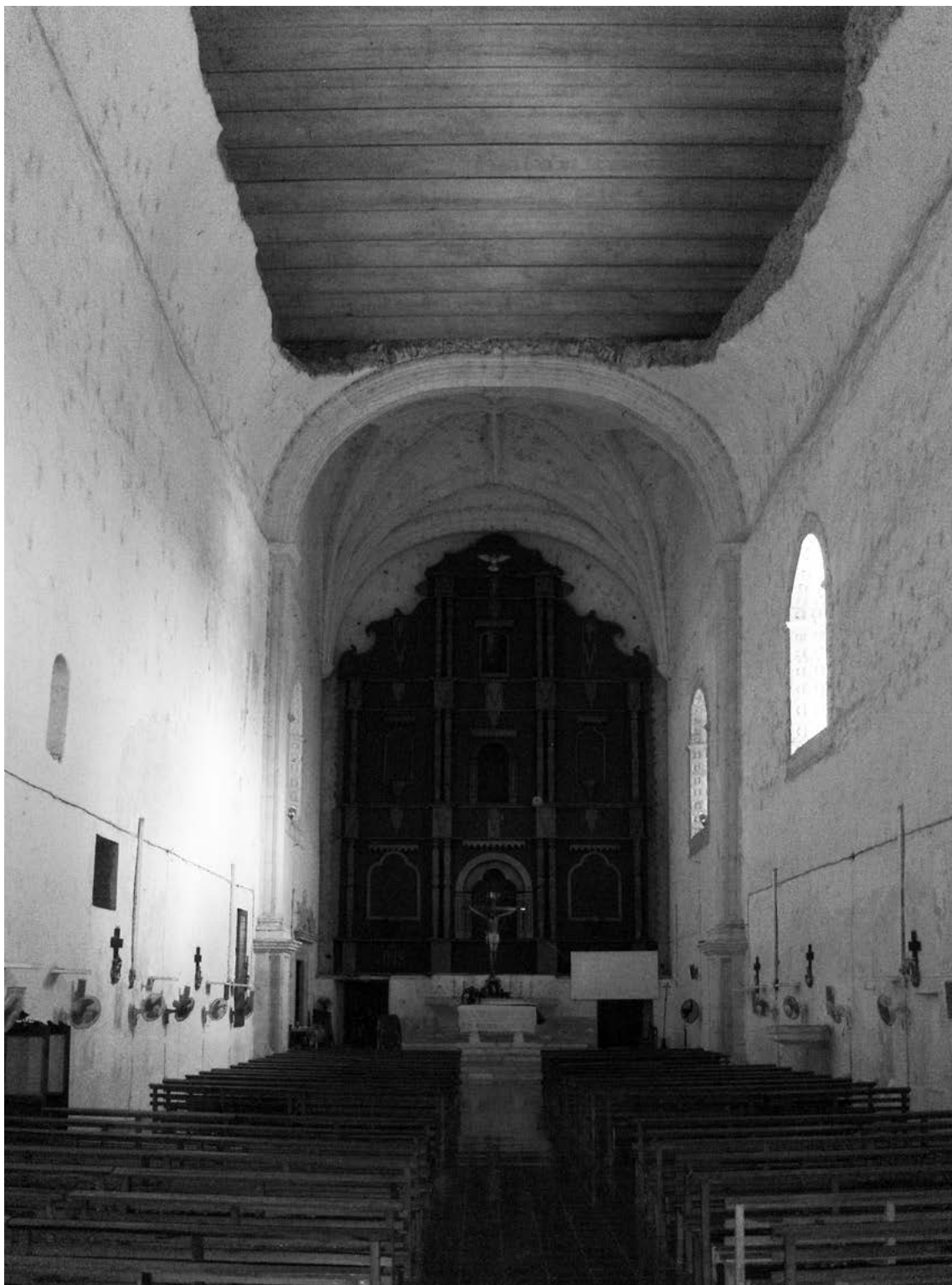
Figura 5. Vista hacia el presbiterio, donde se observa la techumbre de concreto prefabricado y los arranques de la bóveda de mampostería de la nave de la iglesia conventual de Santa Clara, Dzidzantún, Yucatán. Fotografía de los autores.
