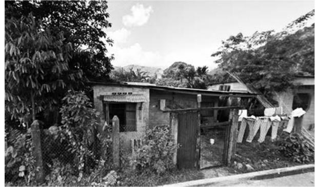
Figura 9. Vivienda edificada en Chapultenango con bloques de material volcánico. Fotografía recuperada de: <<https://www.google.com.mx/intl/es/earth>>.
