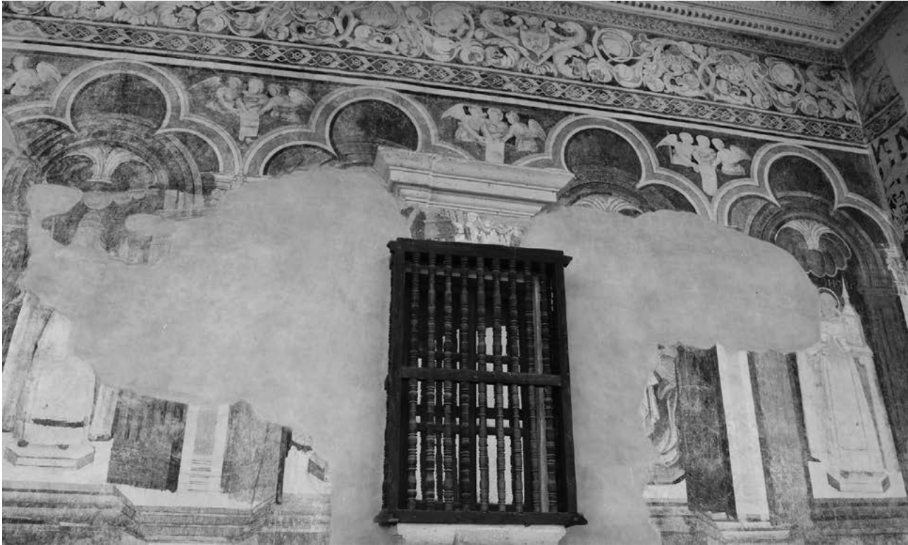
Figura 35. Pintura mural a la altura del quinto y sexto arcos del portal (I). Fotografía de la autora.
