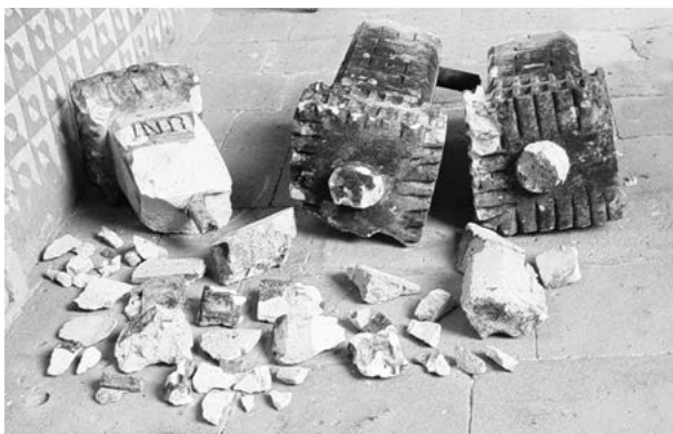
Figura 13. Cruz colapsada. Fotografía de la autora.
