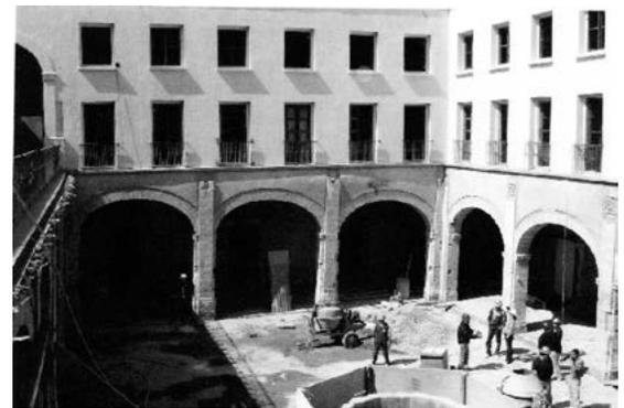
Figura 14. A la izquierda, el patio principal (dos niveles) como estaba antes de la intervención del edificio; a la derecha, el mismo patio en 2004, luego de los trabajos para hacer las viviendas en tres niveles. Se recuperaron los arcos y apareció el pasillo. Fuente: AHJE-CNMH-INAH, exp. Belisario Domínguez, núms. 44-50.
