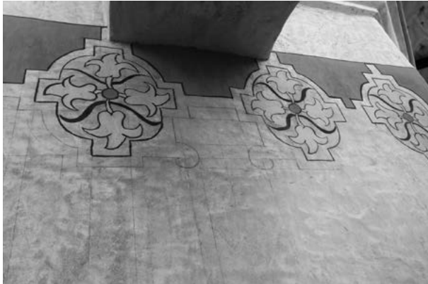
Figura 6. Detalle del proceso de recuperación de la pintura mural en el primer nivel de la cúpula.
