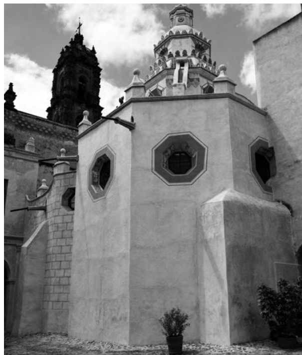
Figura 10. Vista general del camarín, con la recuperación de pintura mural, 2016. Fotografía de Disar. Arquitectura y Diseño.
