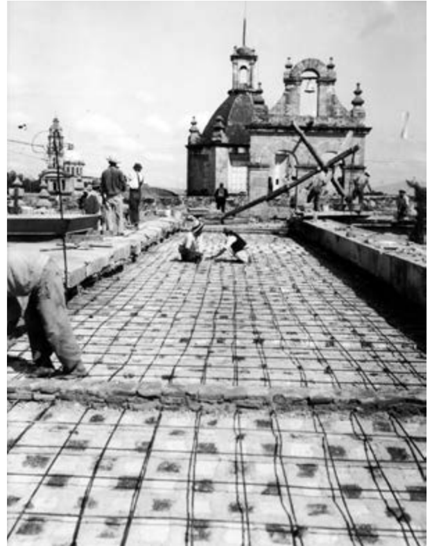
Figura 9. Museo de Guadalajara, colocación del empujillado para una losa de concreto en uno de los techos del edificio, 1925, Fototeca Constantino Reyes Valerio, CNMH-INAH, clasif. 0120-67.
