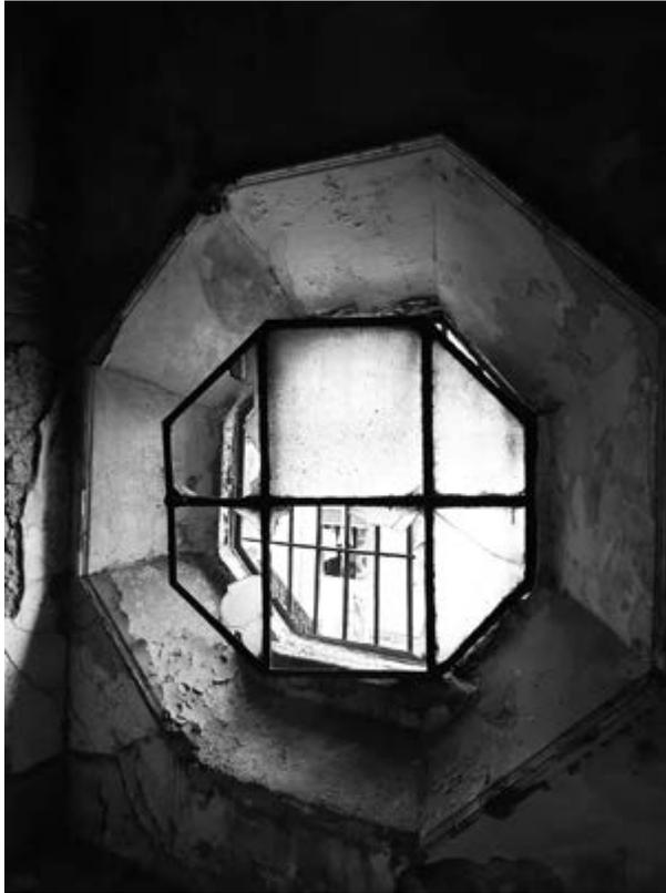
Figura 18. Claraboya ochavada en el muro sur, que ventila y permite el paso de la luz hacia el cubo de la escalera principal del convento. Foto de la autora, 9 de enero de 2019.
