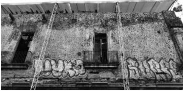
Figura 24. Dos de los tres únicos balcones que se conservan sobre la calle de Corregidora, casi esquina con Jesús María; utilizan cornisas y repisas como elementos de apoyo, lo que marca una relación entre el hierro y el muro que lo acoge para garantizar su buen funcionamiento. Foto de la autora, 9 de enero de 2019.
