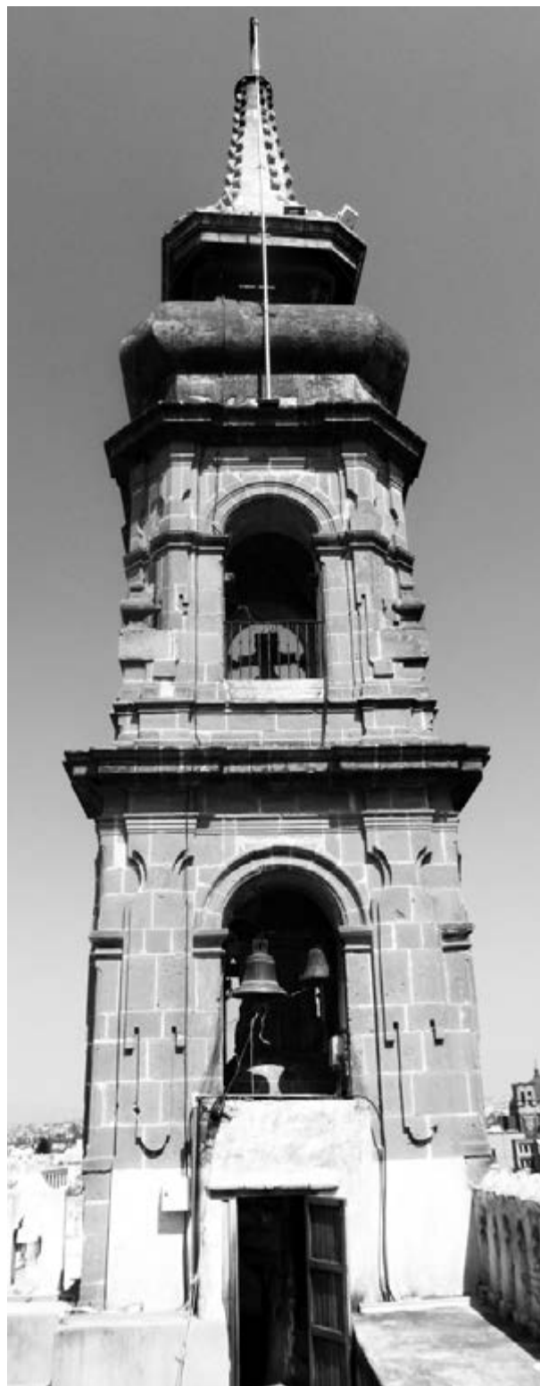
Figura 12. Torre. Fotografía de Mina Ramírez Montes.
