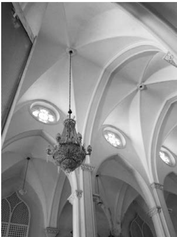
Figura 5. Techo de la nave central. Fotografía de María de Cristo Santos Morales.
