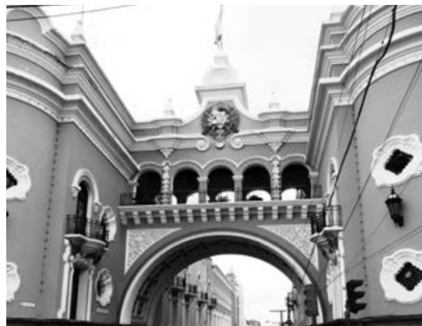
Figura 28. Fachada anterior del pasadizo del antiguo edificio de Correos y Telégrafos, hoy espacio cultural, Guatemala. Fotografía de Aracely Esquivel Vásquez, Miria Esquivel Vásquez y Marcela Dávila Esquivel, 2019.
