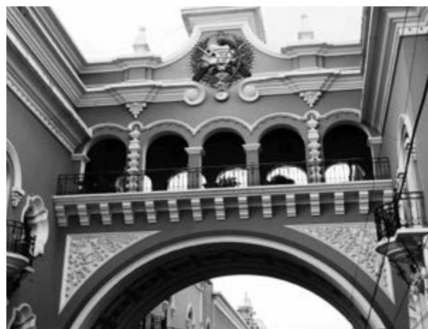
Figura 30. Fachada posterior del pasadizo del antiguo edificio de Correos y Telégrafos, hoy espacio cultural, Guatemala, 2019. Fotografía de Aracely Esquivel Vásquez, Miria Esquivel Vásquez y Marcela Dávila Esquivel.
