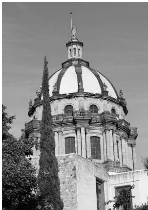
Figura 4. Cúpula del convento de la Purísima Concepción, San Miguel de Allende, diseñado y construido por Zeferino Gutiérrez en 1891. Fotografía de Martín M. Checa-Artasu, diciembre de 2018.
